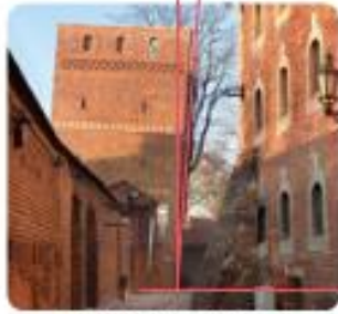
Beszcza miejska w Toruniu zbudowana w XIV w.
